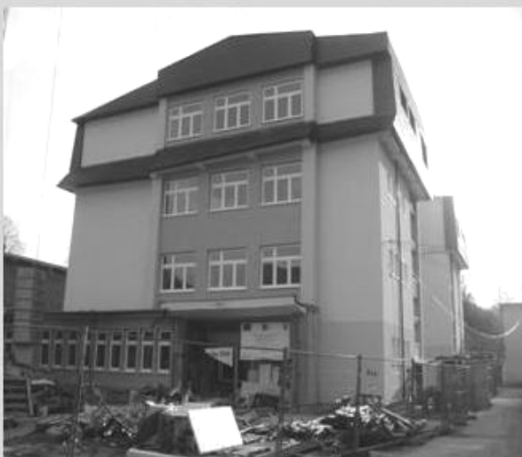
Nadstavba a rekonštrukcia SŠ Belá
